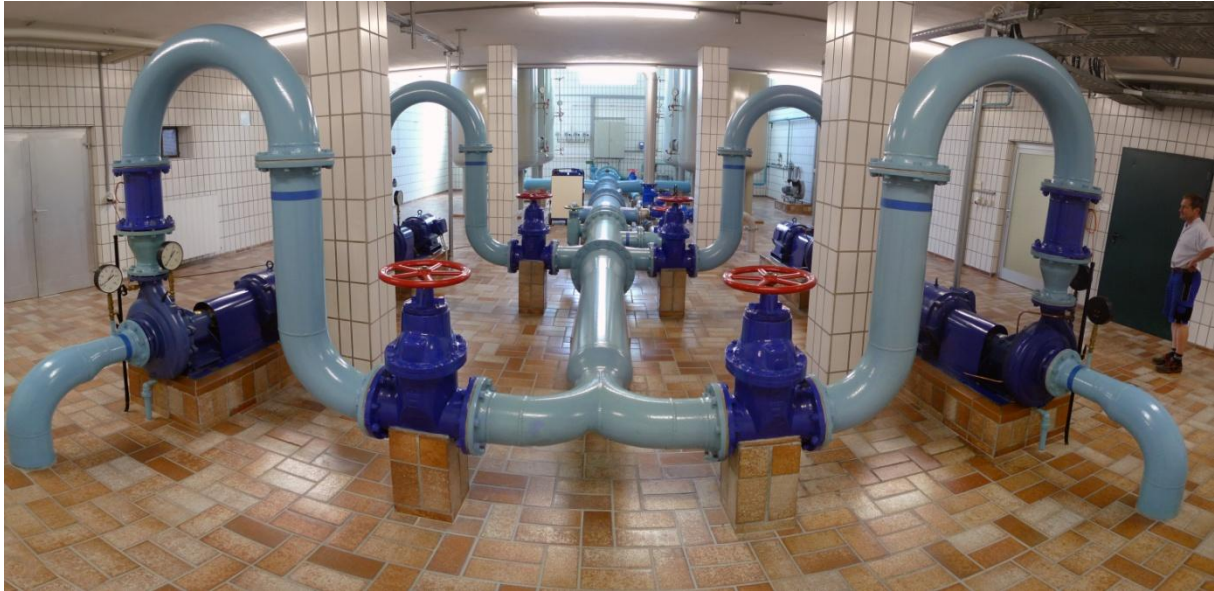
Abbildung 21: Rohr- und Pumpensystem im Wasserwerk Gersthofen
