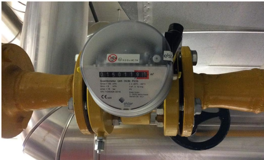
Abbildung 44: Neuer Wärmemengenzähler für die Fahrzeughalle im Bauhof
