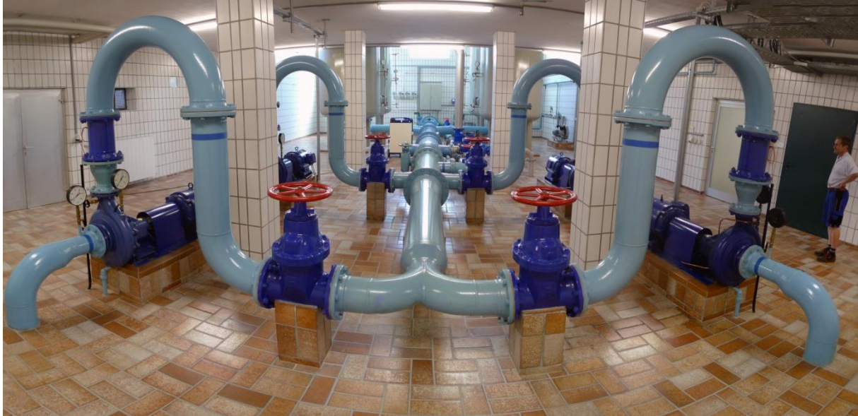
Abbildung 38: Drucksteigerungsanlage im Wasserwerk Gersthofen
