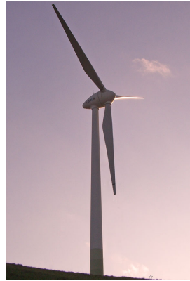
Abbildung (2.1) Horizontalachsenanlage Enercon E-66, Quelle: eigene Aufnahme
