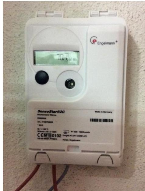
**Abbildung 44:** Neuer Wärmemengenzähler für die Fahrzeughalle im Bauhof
