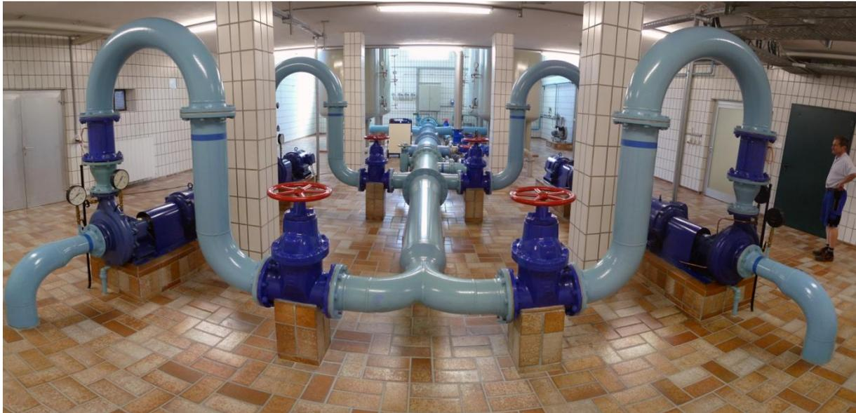
**Abbildung 38:** Drucksteigerungsanlage im Wasserwerk Gersthofen
