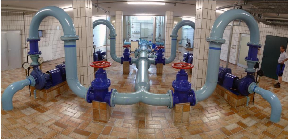
**Abbildung 40:** Drucksteigerungsanlage im Wasserwerk Gersthofen
